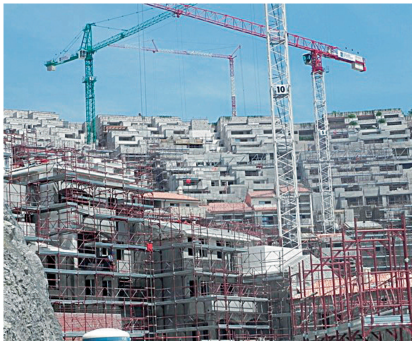
Fase di cantiere.
