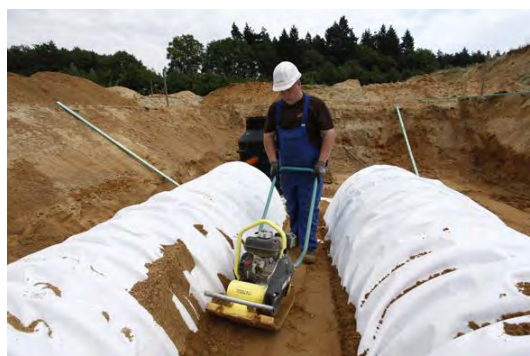
Foto 12: Compattazione con un piccolo dispositivo tra le file di tunnel
