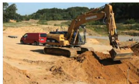
Foto 5: Fase di scavo
