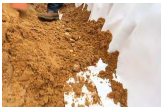
Foto 11: Riempimento sul geotessile per fissarlo
