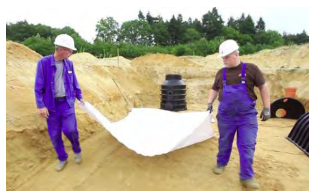
Foto 7: Posa del geotessuto alla base
