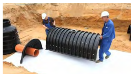
Foto 8: Tubo al pozzetto di afflusso
