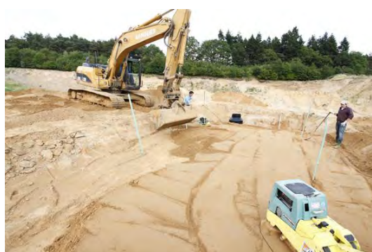
Foto 13: Copertura degli elementi di tunnel
