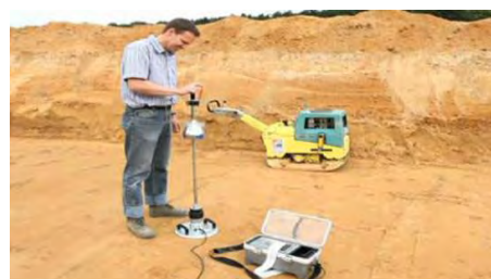
Foto 6: Prova dinamica su piastra a fondo scavo
