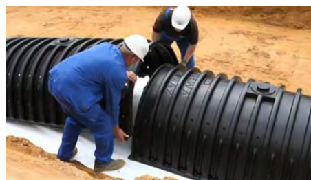
Foto 9: Connessione di due elementi di tunnel mediante sovrapposizione
