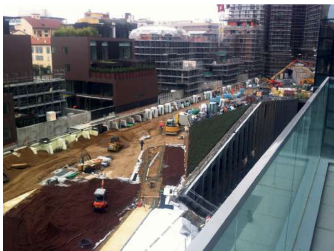
Vista cantiere Porta nuova Varesine, Milano.
