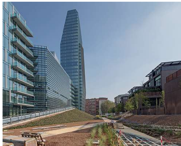
Vista cantiere Porta nuova Varesine, Milano.
